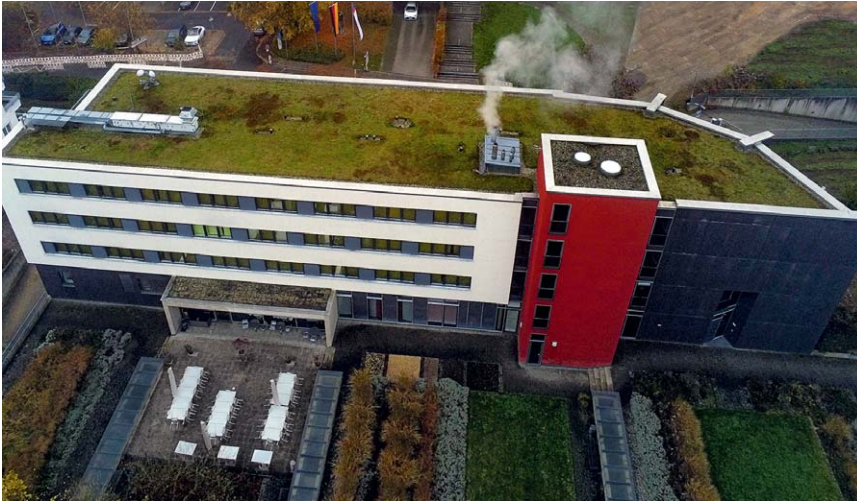
Das Gästehaus der Carl-Oelemann-Schule in Bad Nauheim.
